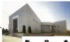
新校舎 (昭和60年3月竣工)
