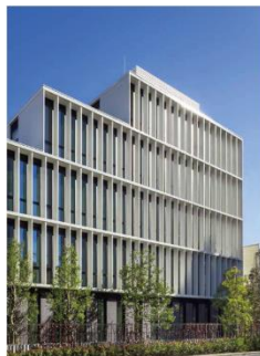
第一看護学科棟
